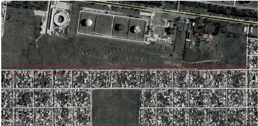
Ilustración I: Imagen general Calle 7 entre Calles 131 y 143 – Berisso
