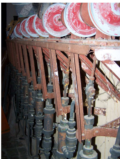
Detalle de dosificadores de la antigua planta potabilizadora
