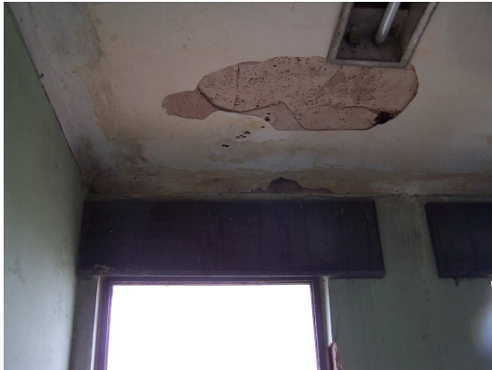
Detalles de degradación del cielorraso por ingreso y circulación de agua de lluvia
