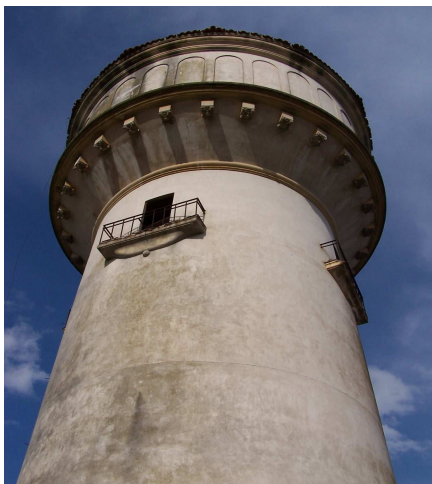
Vista del tanque
