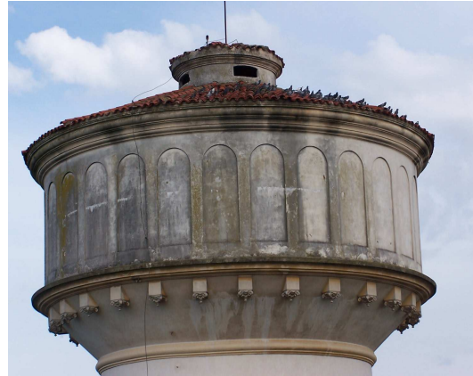
Vista de alteraciones por lixiviación de sustancias componentes del mortero del revoque
