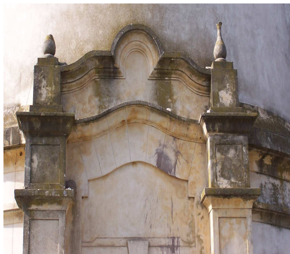
Detalle de molduras y ornamentos, se observan depósitos blanquecinos y crecimiento biológico
