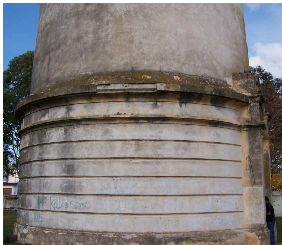
Vista del basamento del tanque, se observan deterioros
