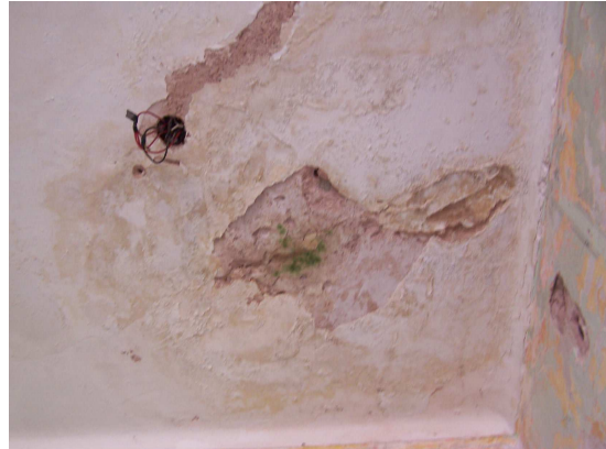
Detalles de degradación del cielorraso por ingreso y circulación de agua de lluvia
