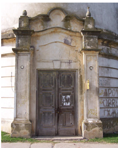
Vista del portal de acceso al tanque
