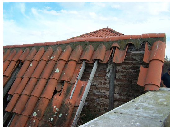
Detalle de alero. Se observa degradación de la estructura y ausencia de tejas
