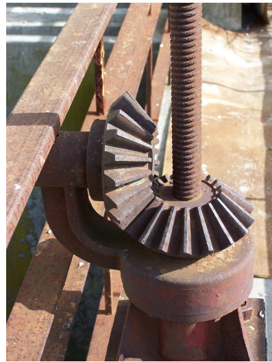
Detalle de dispositivo metálico para apertura de compuertas
