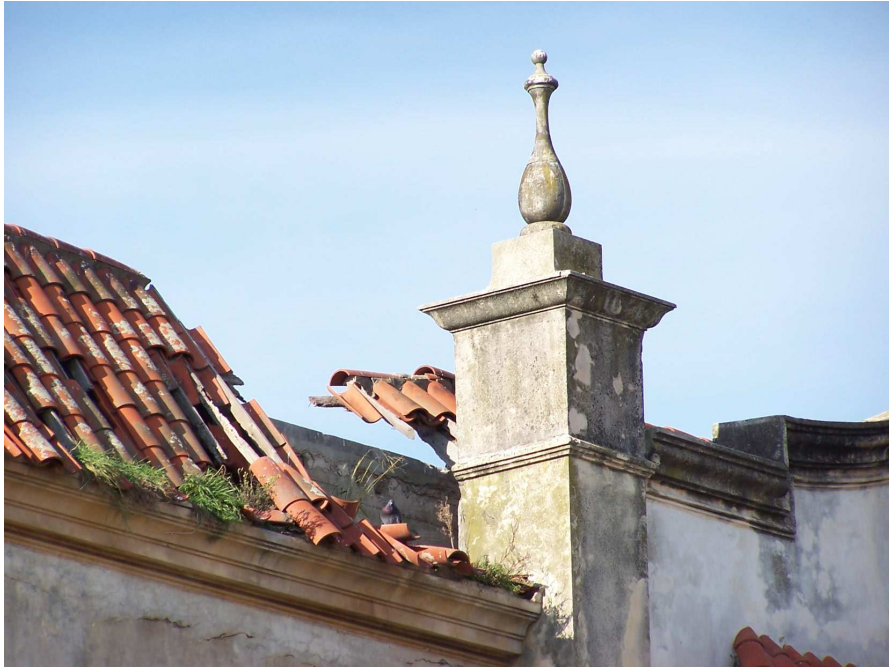
Detalle de coronamiento del frente y vista del deterioro del alero
