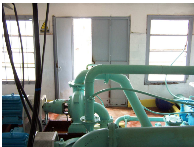
Vista general de Sala de Bombas
