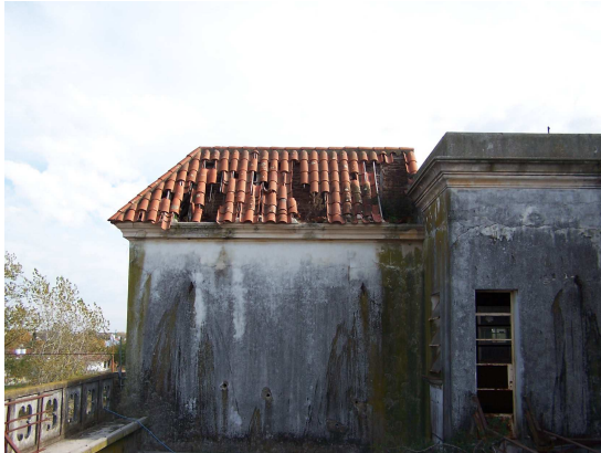
Vista de degradación de revoques
