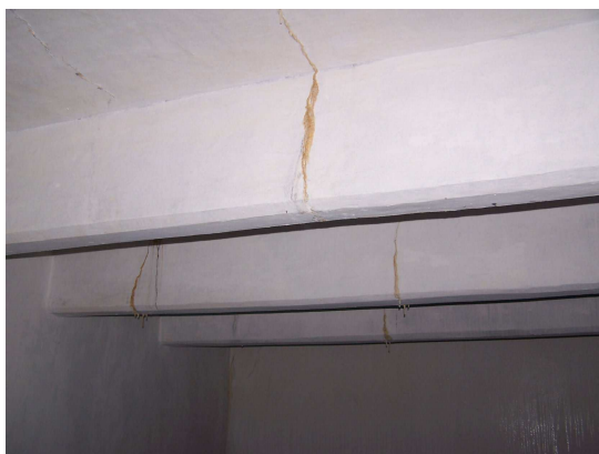
Se observan fisuras en vigas y losas con depósitos blanquecinos
