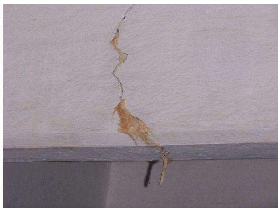
Detalle de fisura en viga. Se observa depósito blanquecino y formación de estalactitas
