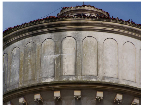
Vista de depósitos blanquecinos sobre revoques
