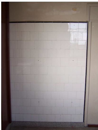
Detalle de revestimiento de azulejos en muro de laboratorio
