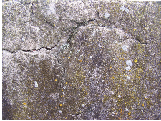
Detalle de degradación de revoques
