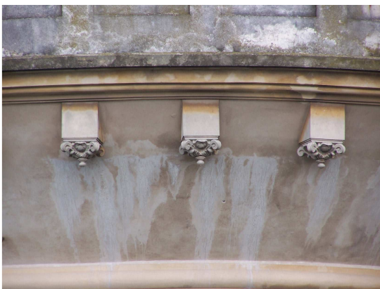
Vista de depósitos blanquecinos sobre revoques
