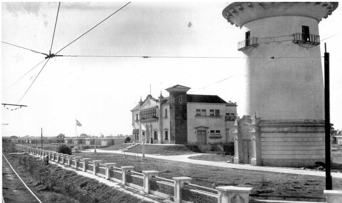
Planta de Tratamiento y Tanque Elevado. 1962 1
