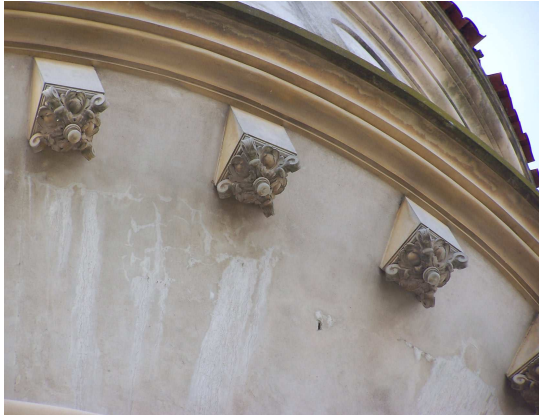
Vista de alteraciones por lixiviación de sustancias componentes del mortero del revoque
