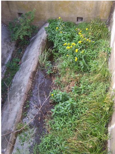
Vista de crecimiento de vegetación en piletas a cielo abierto
