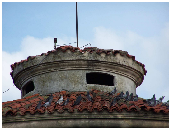
Vista de cubierta de tanque
